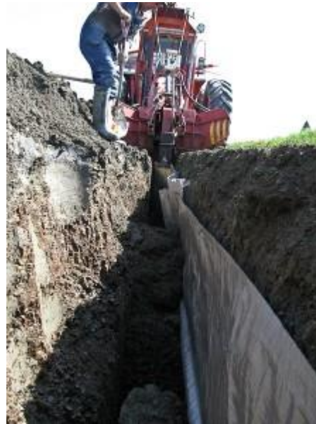
Kuva 12. Periaatekuva lisäveden pumppaamisesta ja muovikalvon sijoittamisesta säätösalojitetulle happamalle sulfaattimaalle. (Kuva: Rainer Rosendahl)
